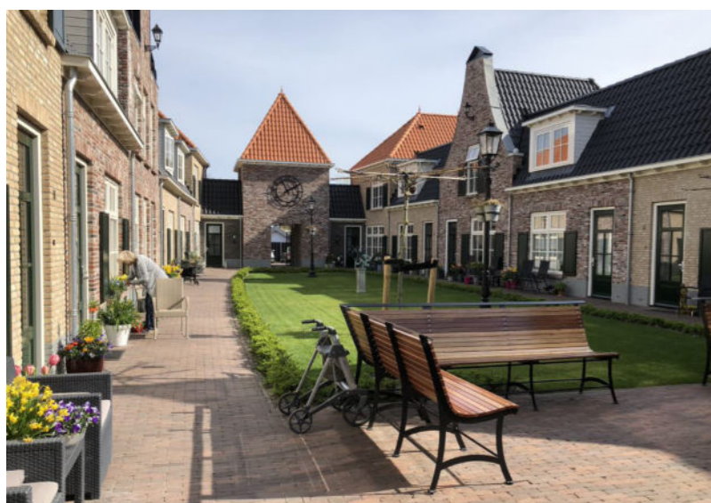
FIGUUR 22: Het Polder Hofje, Anna Paulowna. Een klein dorp voor 'senioren' met 20 koopwoningen en de Orangerie: een centrale plek waar mensen samen kunnen komen om bijvoorbeeld te klaverjassen. Daarnaast zijn er twee torens die als slaapvertrek worden verhuurd aan familieleden.
