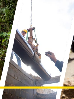
bestaande en nieuwe riolering
